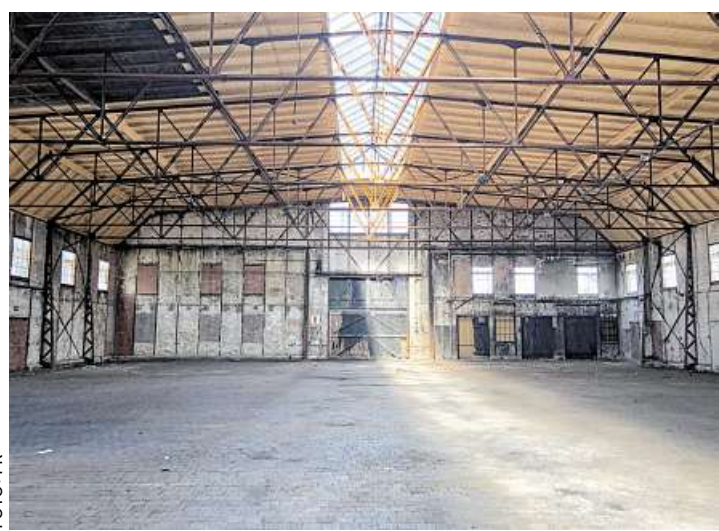
Die Fliegerhalle von innen: Die Projektentwickler planen in dem Industriebau ein großes und ein kleines Schwimmbecken. FOTO: FR
