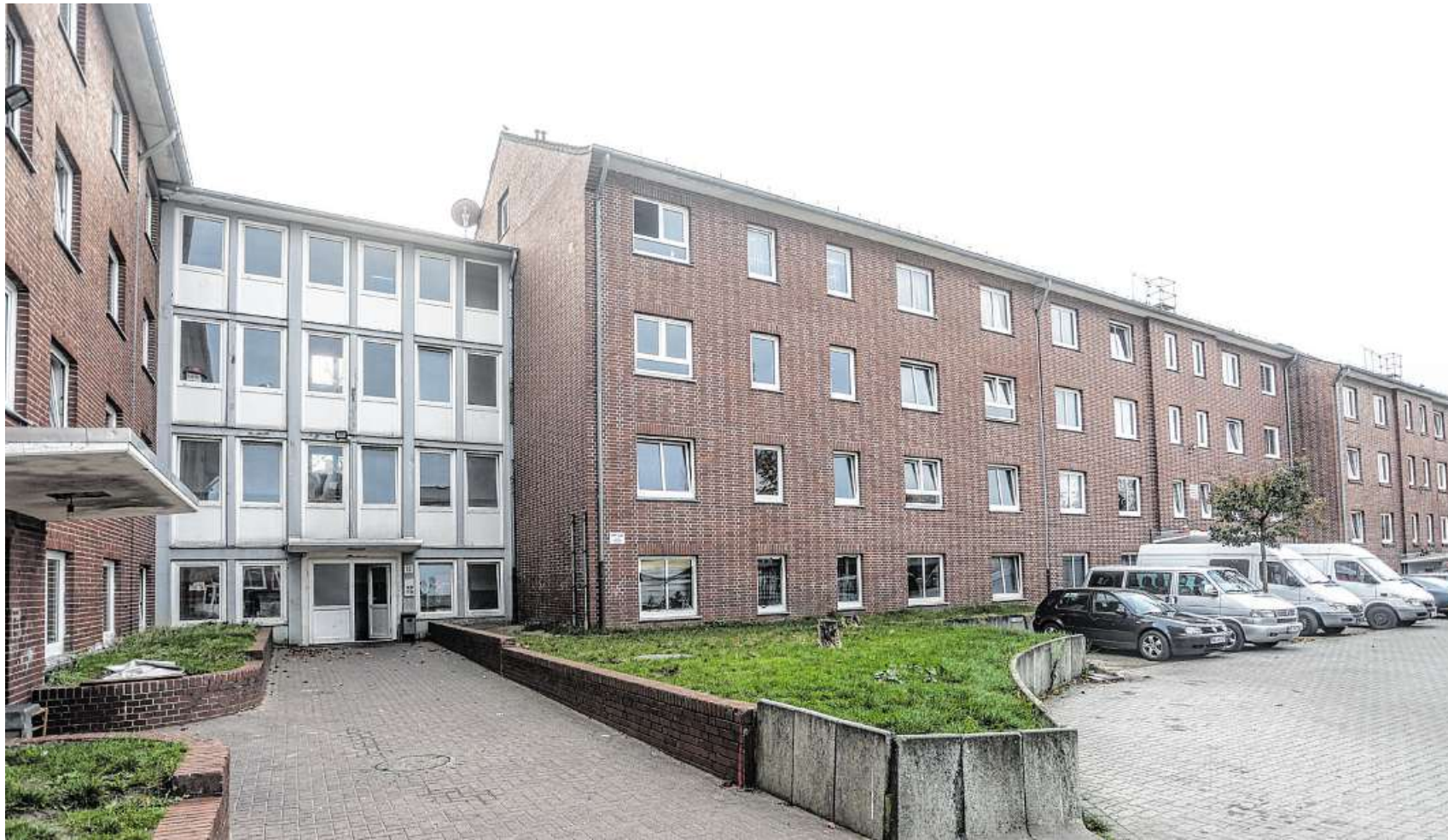
Die Stadt will die Mehrfamilienblöcke an der George-Albrecht-Straße erwerben. Zurzeit herrschen hier „ungesunde Wohnverhältnisse“ vor.
