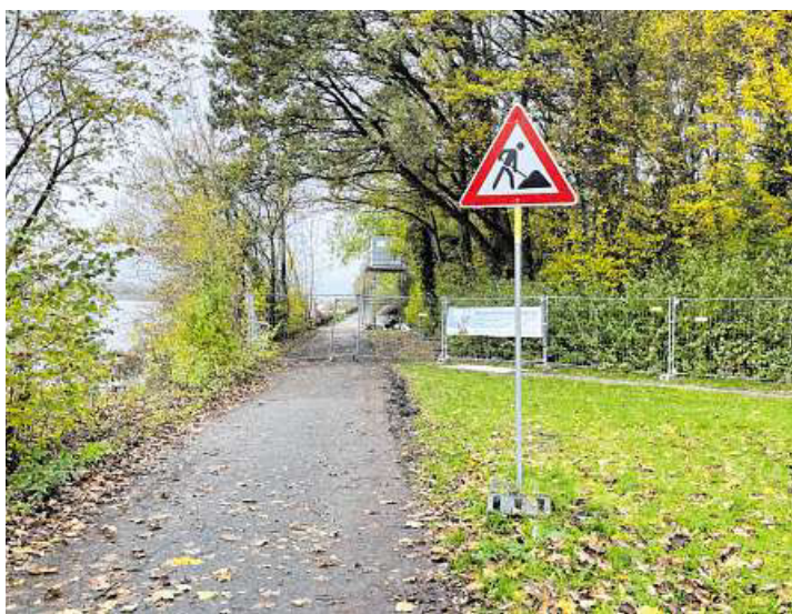
Achtung, Bauarbeiten! Im Mai vergangenen Jahres ist das Rönnebecker Weserufer für Radfahrer und Fußgänger gesperrt worden.
